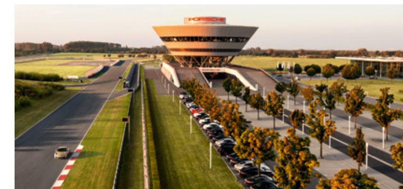
Circuit et Centre Clients Porsche
